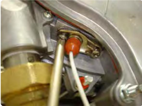
2. Retirer deux (2) vis Phillips fixant l'électrode d'allumage à l'échangeur thermique de la chaudière.
