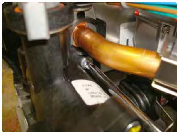
**Figure 158** Dépose de l'échangeur thermique à plaques plates (vis à droite) (Combinée uniquement 80/120 illustrée).
