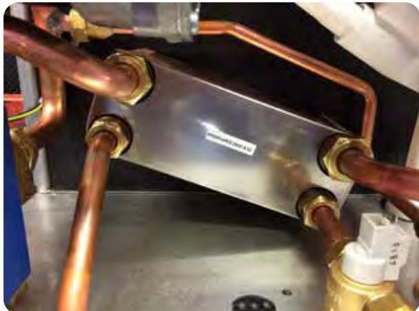
5. La durée du traitement doit être choisie en fonction de la quantité de dépôts de tartre présents dans l'échangeur et néanmoins, cette durée doit toujours être inférieure à la durée de traitement maximale spécifiée par le fabricant sur la fiche technique du produit.
