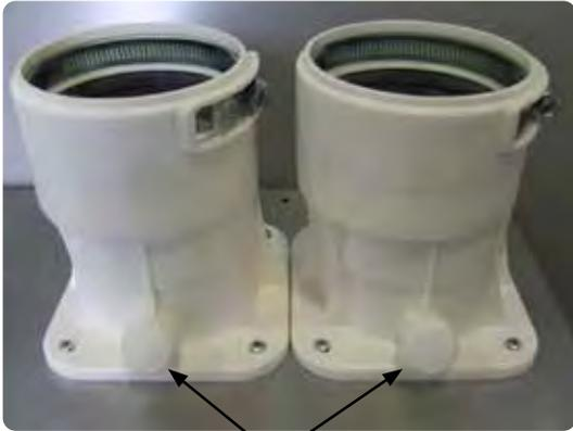
Adaptateurs d'évent et d'air à installer avec des prises d'essai faisant face à l'avant de la chaudière. Doivent être fermées et verrouillées.
