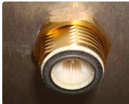
6. Chaudière combinée : Raccordement d'entrée d'eau sanitaire montrant la crépine protégeant le régulateur de circulation d'eau à palettes du sable et d'autres débris.
