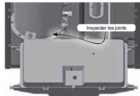
Figure 116 Inspecter les joints de l'échangeur de chaleur au plat à condensat.
